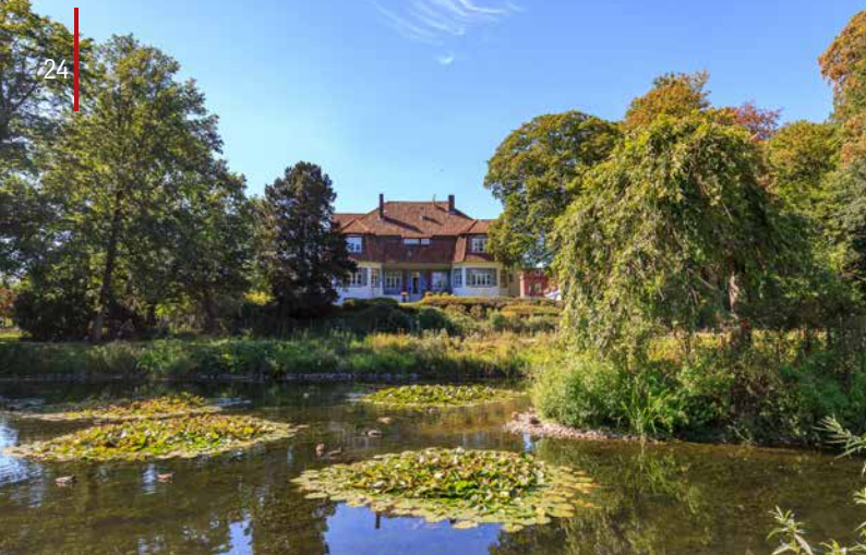
Der Teich mit Blumeninsel (re.) in Blickrichtung West. Im Hintergrund das um 1907 errichtete „neue Pächterhaus“ als neuer Wohnsitz für den „Amtsman zu Marienwerder“
