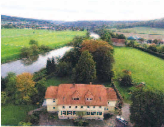
Klostergut Hilwartshausen, Pächterwohnhaus 28)
