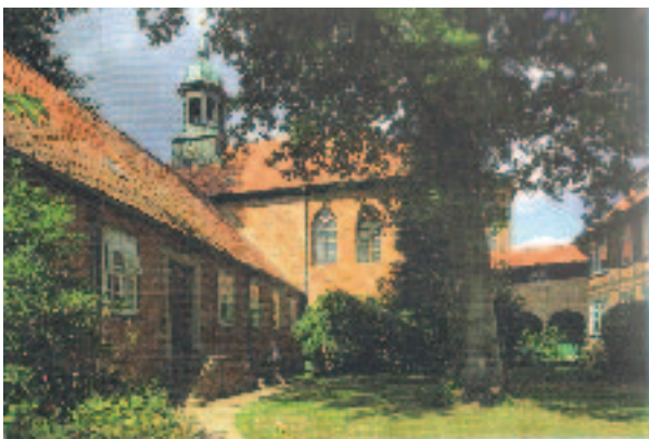
Kloster Walsrode: Langer Gang, Klosterchor und Äbtissinnenhaus (r.) 17)
